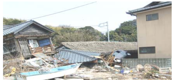
大津漁港付近 津波の後の様子
